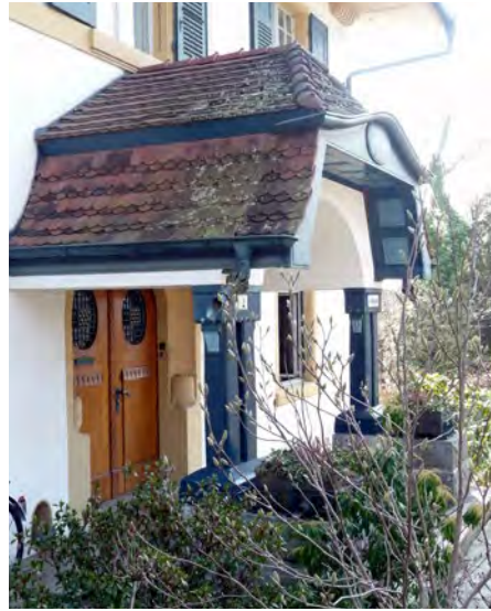
Abb. 11: Die Villa Nussbühl hebt sich nicht durch eine verkrampte Farbvielfalt hervor, sondern lediglich durch klare, in der Palette bewusst beschränkte Farbfassungen der ohnehin notwendigen, unterschiedlichen Materialien. Wie diese Elemente, so sollte auch das sogenannte «Kronendach» (paarweise übereinander gelegte Ziegelreihen, vgl. Abb. 6, 9) der Dachhaut durch seine waagrecht verlaufenden Schattenstreifen schon weithin sichtbar eine charaktervolle Struktur verleihen (Fotos: Matthias Walter).
