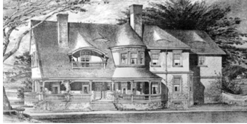
Abb. 8: Dieses amerikanische Landhaus von 1885 bei Catonsville (Maryland) (Architekten Wilson, Baltimore) ist für seine Zeit und Gegend typisch und enthält wesentliche Eigenschaften, die auch für den deutschen Landhausbau um 1900, die Villa Nussbühl und die Einfamilienhausbewegung überhaupt kennzeichnend sind: Baumbestandene, lediglich von niedrigen und deshalb nicht abweisenden Mauern eingefriedete Gartenumgebung, einen trotz Auskragungen und Versetzungen kompakten Baukörper mit horizontaler Wirkung, Terrasse, breitem Runderker sowie weit herabgezogenem Dach mit physiognomisch wirkenden Fenstern und Gauben (Aus: American Architect and Building News , 1886, T. 545).
