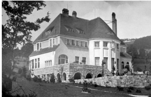
Abb. 9: Die Villa Sombart in Mittelschreiberhau im niederschlesischen Riesengebirge (heute Szklarska Poreba in Polen), erbaut 1906–08 von Fritz Schumacher, wirkt in ihrer Ähnlichkeit im Terrassenaufbau und in der Gestaltung des Runderkers und dessen Verhältnis zum Baukörper wie ein direktes Vorbild für die Villa Nussbühl , obwohl nicht gesichert ist, ob Lanzrein & Meyerhofer das kaum ältere Bauwerk kannten. Nicht zuletzt durch das gemeinsame Vorbild des amerikanischen Landhauses (vgl. Abb. 8) ist aber auch die Verwandtschaft dieser beiden rund 1000 km auseinander liegenden Villen sicher nicht zufällig (aus: Moderne Bauformen [1912] S. 222).
